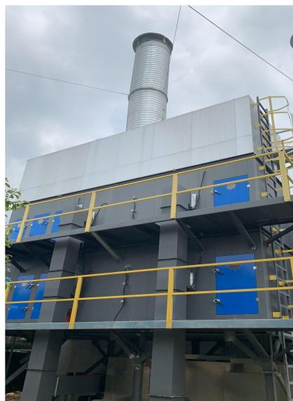
图 4-5 油漆废气：“水喷淋+低温等离子+
