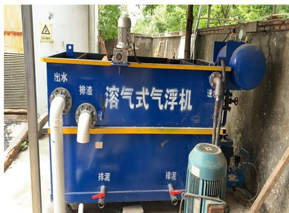
图 4-1 喷淋废水处理设备照片
