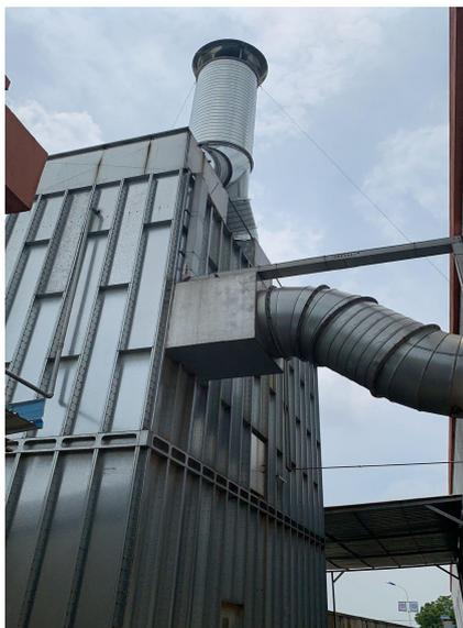
图 4-2 下料粉尘：布袋除尘装置照片
