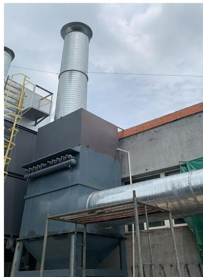
图 4-3 打磨粉尘：布袋除尘+水喷淋装置照片
